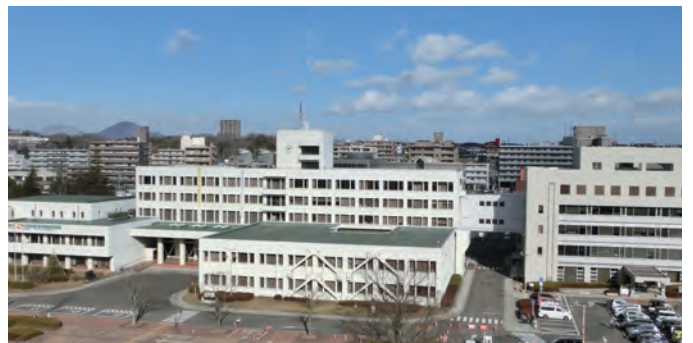
建て替え予定の泉区役所
