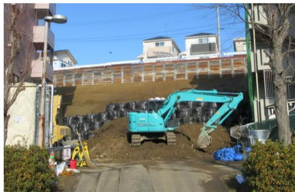
復旧が進む市道法面崩壊現場
