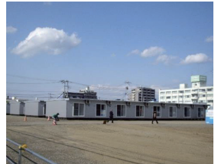
建設中のプレハブ仮設住宅
